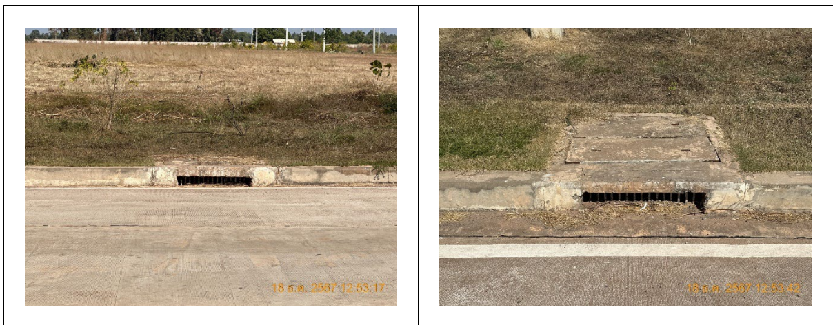
รูปถ่ายที่ 3.2-2 : ระบบระบายน้ำฝนของโครงการ
